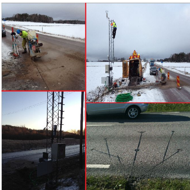
Figur 16: Installation av ett BIRDS-system. Nedre högra bilden visar det färdiga resultatet.
